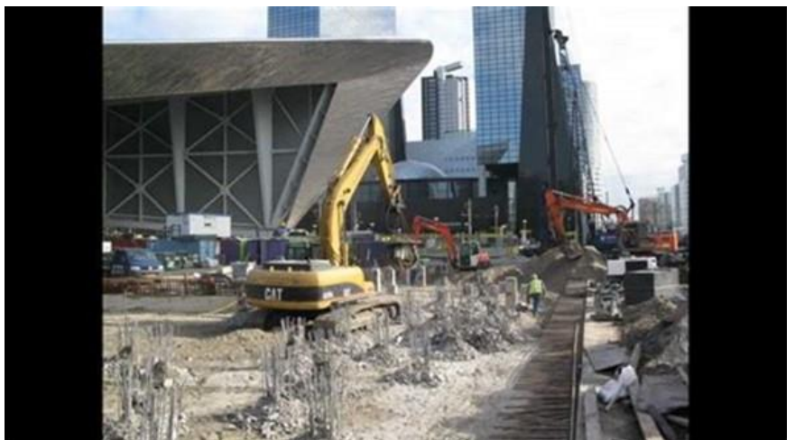
De Rotterdamse bouwput
